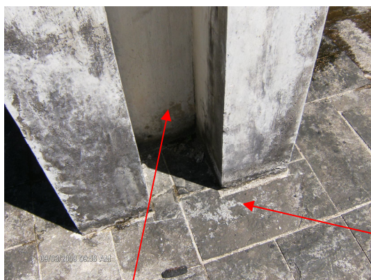
Detalhe do pilar da lâmina por onde correrá o cabo de descida e o piso acabado a ser atravessado
