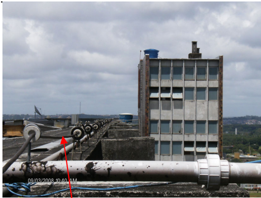
Gaiola de faraday está incompleta, existe de um lado mas do outro lado não existe
