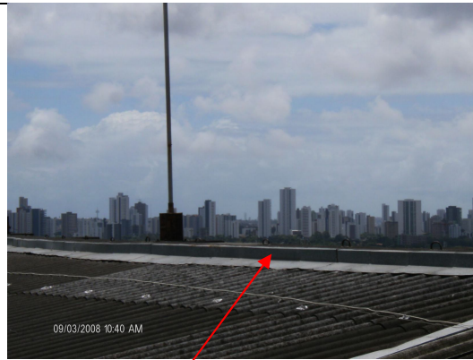
Gaiola de faraday está incompleta, existe de um lado mas do outro lado não existe
